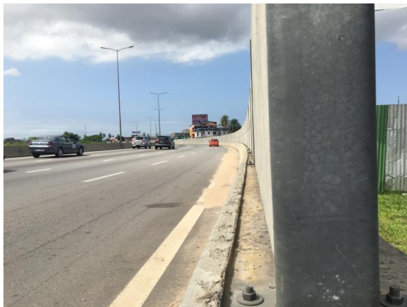
Figure 70: Exemple d'un mur anti-bruit (le long du troisième pont à Abidjan)
